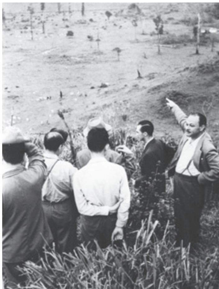
Visita ao terreno escolhido para a construção da Usina Intendente Câmara 1958
