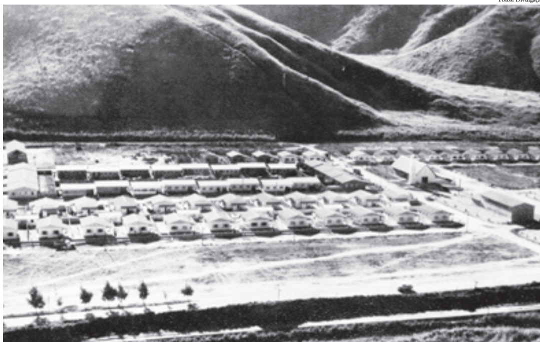
Bairro Horto em construção
